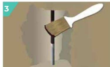
3 Si les aciers ne sont pas recouverts immédiatement, appliquer **RÉPAFER** ou **PASSIFER** afin d'éviter le développement de corrosion.
